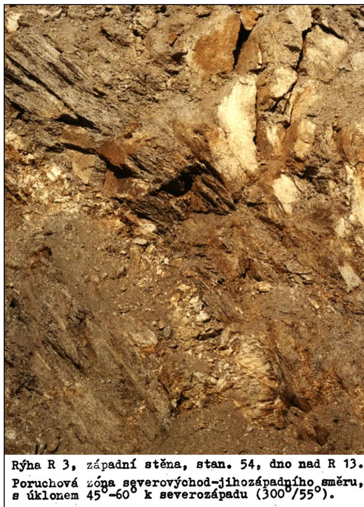
Obr. 108 Historická fotografie z dokumentace rýhy R3 ve východní části hlavního staveniště ETE zachycující "poruchovou zónu" v biotit-sillimanitické pararule v okolí průniku granitické horniny. Pod fotografií je uveden i autentický popis fotografie (převzal I. Prachař z podkladu [L. 144]).
