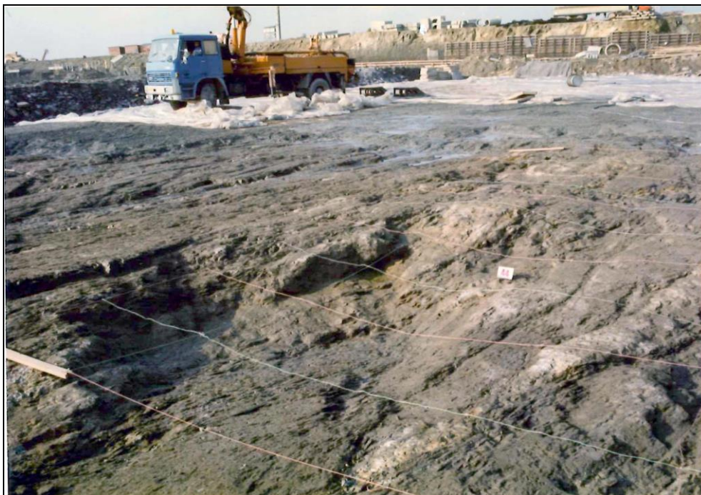
Obr. 129 Dobová fotografie odhalené základové spáry reaktorovny 2. HVB (pole č. 44) (převzal I. Prachař z podkladu [L. 96]).
