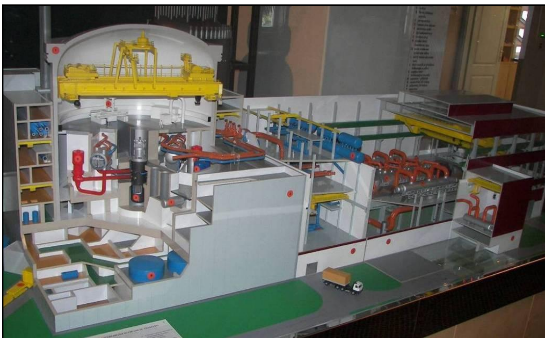
Obr. B.I.33: Schéma bloku VVER 1000 stávající jaderné elektrárny Temelín
